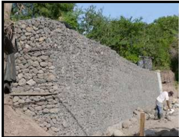
Construcción de muro de gavión para protección de rivera de río aguas abajo
